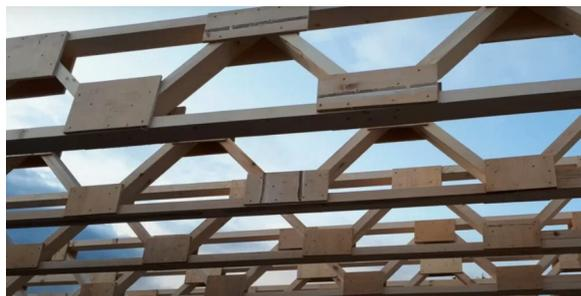
*а* – тавровая деревянная балка; *б* – решетчатая деревянная балка
