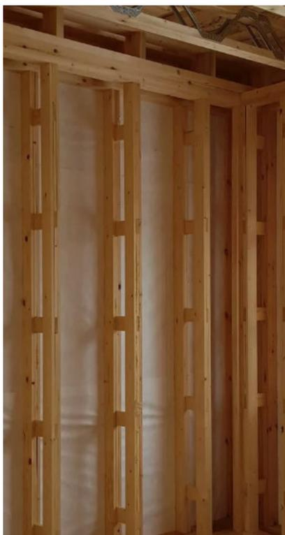
**Рисунок 10.9 – Пример двухветвевой деревянной стойки**
