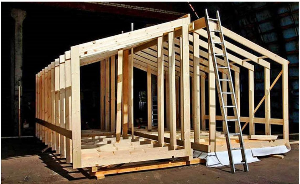
*а* – каркасная конструкция; *б* – каркасно-панельная конструкция верхнего, или отдельно стоящего модуля
