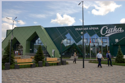
«ФОК с ледовым полем г. Сатка» ЗАО «Востокметаллургомонтаж»
