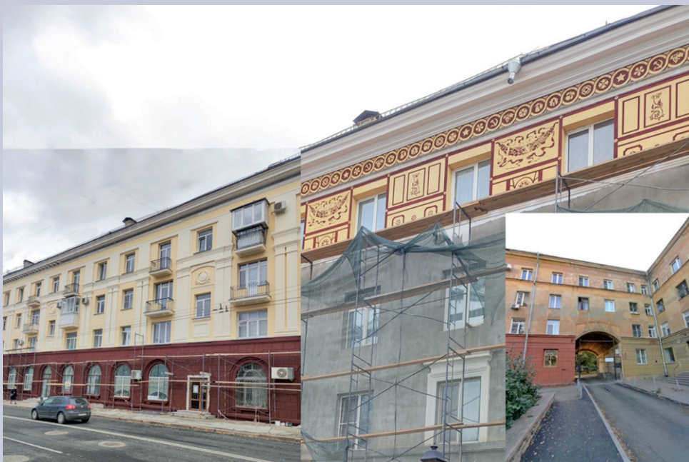
На фото: фасады МКД до и после капитального ремонта
