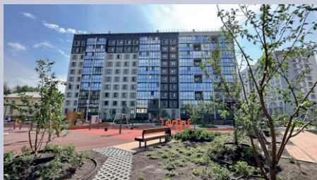
ЖК «MOTIVE» (г. Челябинск, ул. Ереванская) ООО «Бетотек Застройщик»
