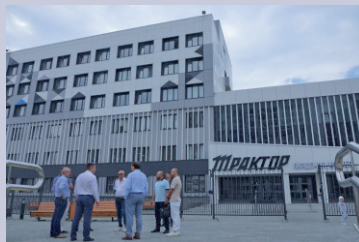
Региональный центр олимпийской подготовки по хоккею Челябинской области ООО СК «СтройДом» / ООО «УРАЛЭНЕРГО»
